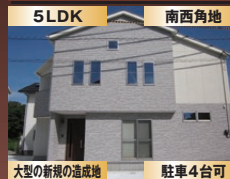
大型の新規の造成地 駐車4台可
